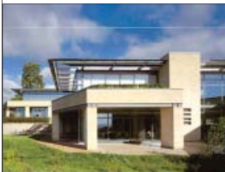
Figure 1. Le siège social de Wessex Water a obtenu une des meilleures évaluations environnementales pour un immeuble dans le Royaume-Uni. Sa charpente d'acier intègre des planchers en béton préfabriqué.
