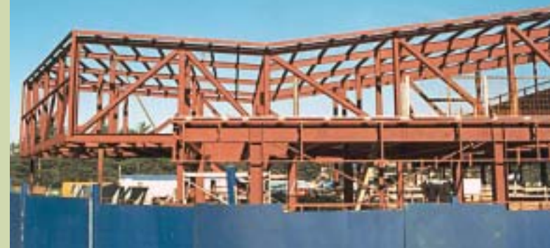
Le 2 e vie des poutres du ROM au Centre étudiant de l'Université de Toronto
