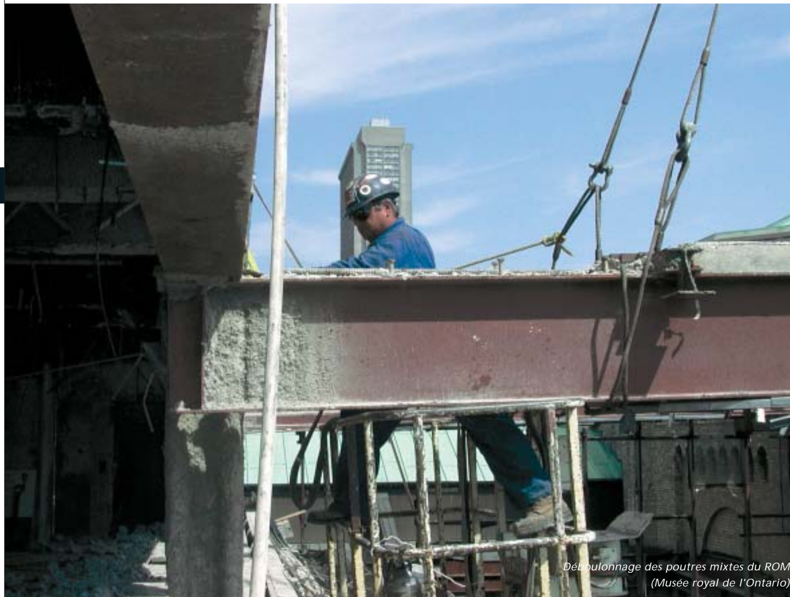
Le 2 e vie des poutres du ROM au Centre étudiant de l'Université de Toronto
